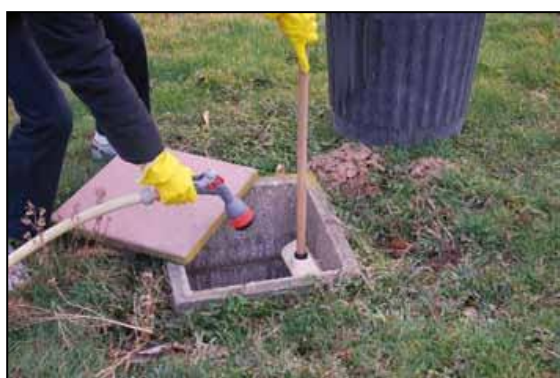
Nettoyage périodique des regards de visite
