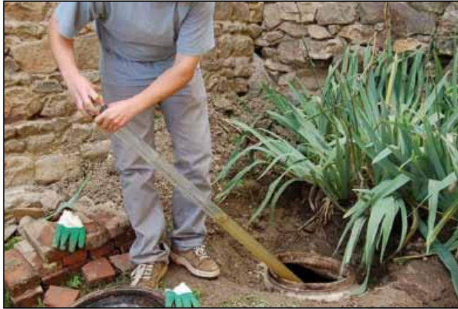
Mesure du niveau de boue par un technicien du SPANC
